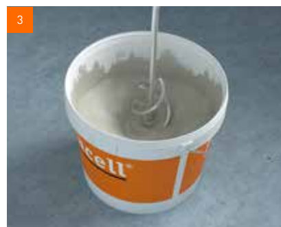
Promíchání vhodným míchadlem při nízkých otáčkách až vznikne homogenní, bezhrudková samonivelační hmota
