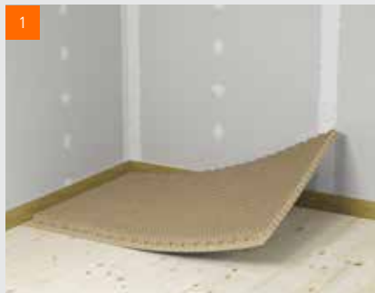
Pokládka podlahové voštiny fermacell™
