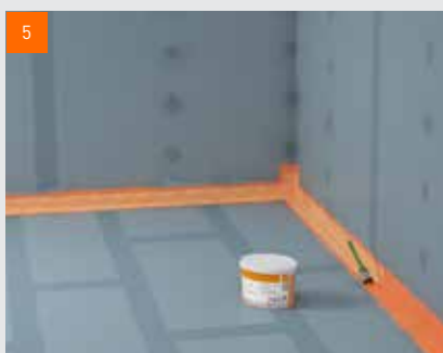
5 Těsnící pás přetřete ihned po přitlačení tekutou fólií fermacell™
