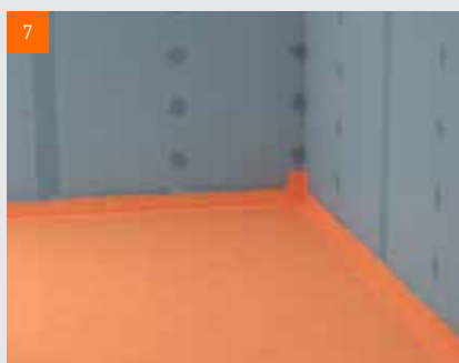
7 Při použití sádrovláknitých podlahových prvků ve třídě W 1-I je nutná celoplošná aplikace těsnícího systému. Tekutá fólie fermacell™ se nanáší ve dvou vrstvách válečkem při tl. vrstvy nátěru min. 0,5 mm. Pro druhý nátěr se přibalovaný pigment, který je součástí balení tekuté fólie fermacell™, dobře rozmíchá v odpovídajícím množství tekuté fólie. 1. nátěr: aplikace tekuté fólie fermacell™ bez přidaného pigmentu a následné proschnutí
