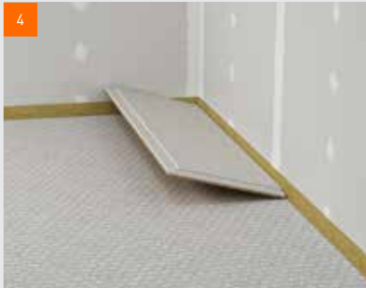
Pokládka podlahových prvků fermacell®
