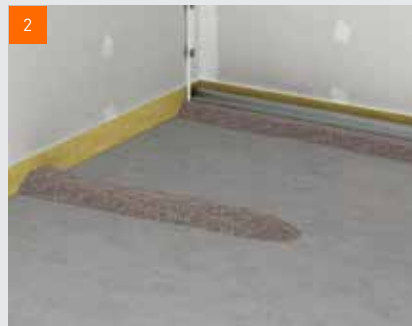
Násyp akustického podsypu fermacell™
