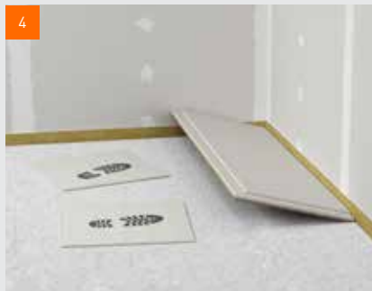
Pokládka podlahových prvků fermacell® na vyrovnávací podsyp fermacell™
