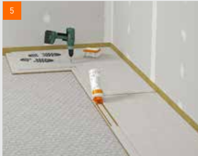
Spojování jednotlivých podlahových prvků fermacell®
