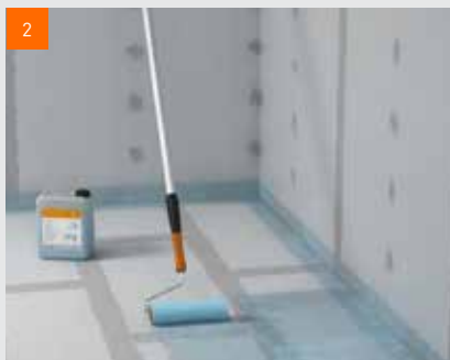
2 ... a pomocí válečku potom také na podlahu
