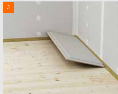
3 Založení prvního podlahového prvku fermacell®
