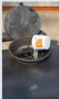
Míchání: 8 pytlů voštinového zásypu fermacell™ + 1 kbelík kameninového pojiva fermacell™
