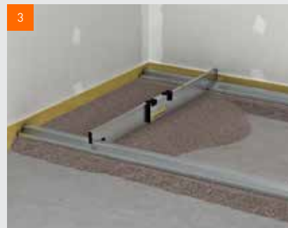
Akustický podsyp fermacell™ se aplikuje mezi připravené násypy a pomocí stahovací latě
