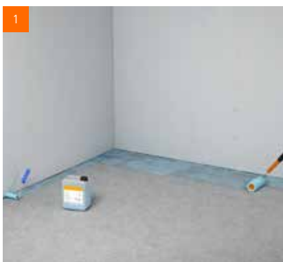
1 Příprava podkladu hloubkovou penetrací fermacell™
