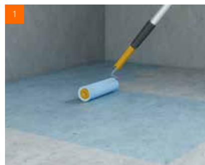
Příprava: penetrace podlahy
