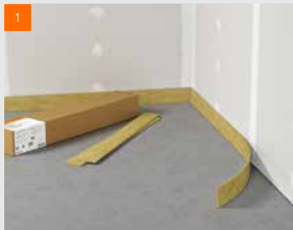
Upevnění okrajových izolačních pásek
