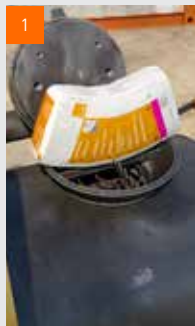
Míchání: 8 pytlů voštinového zásypu fermacell™ + 1 kbelík kameninového pojiva fermacell™
