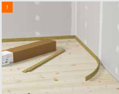
1 Položte okrajové izolační pásky a v rozích sražte na tupo
