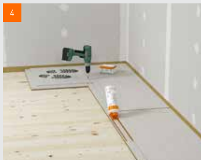
4 Nanášení podlahového lepidla fermacell™ na polodrážky
