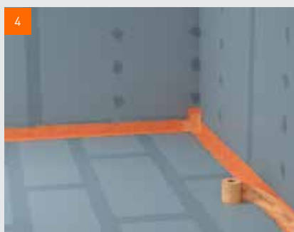
4 Do vlhké tekuté fólie vtlačte těsnící pásky fermacell™
