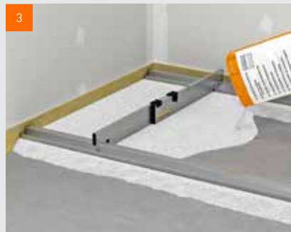
Aplikace vyrovnávacího podsypu
