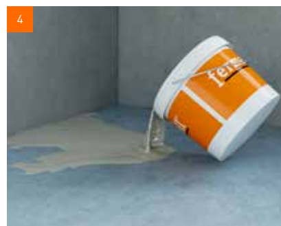
Nivelační hmotu vylijte a vyrovnajte
