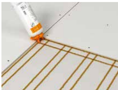
K zajištění dokonalého prolepení hran desek třetí vrstvy se lepidlo nanese také podél hrany sousední desky
