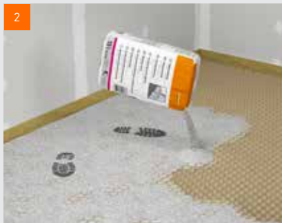
Vyplnění voštiny voštinovým zásypem fermacell™
