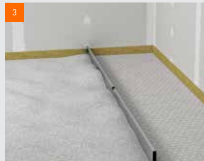
Zarovnání voštinového zásypu fermacell™
