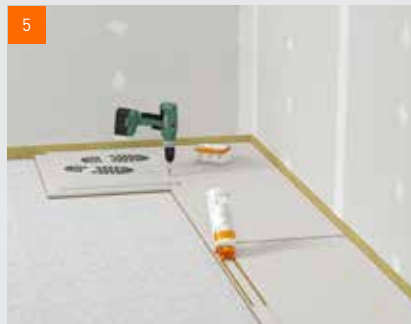
Pokládka podlahových prvků fermacell® na vyrovnávací podsyp fermacell™
