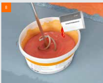
8 2. nátěr: přibalovaný pigment se dobře rozmíchá a tónovaná tekutá fólie fermacell™ se nanese v požadované vrstvě min. 0,5 mm. U druhé vrstvy nátěru doporučujeme změnit směr nanášení, např. kolmo na první vrstvu. Detailní informace k produktu najdete v Technickém listu
