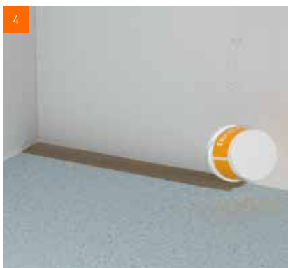
4 Připraví se první břeh pro stahovací lať
