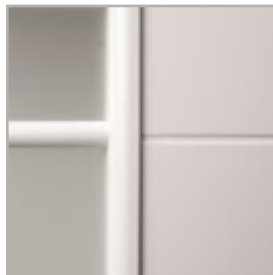
pohled na frézování
